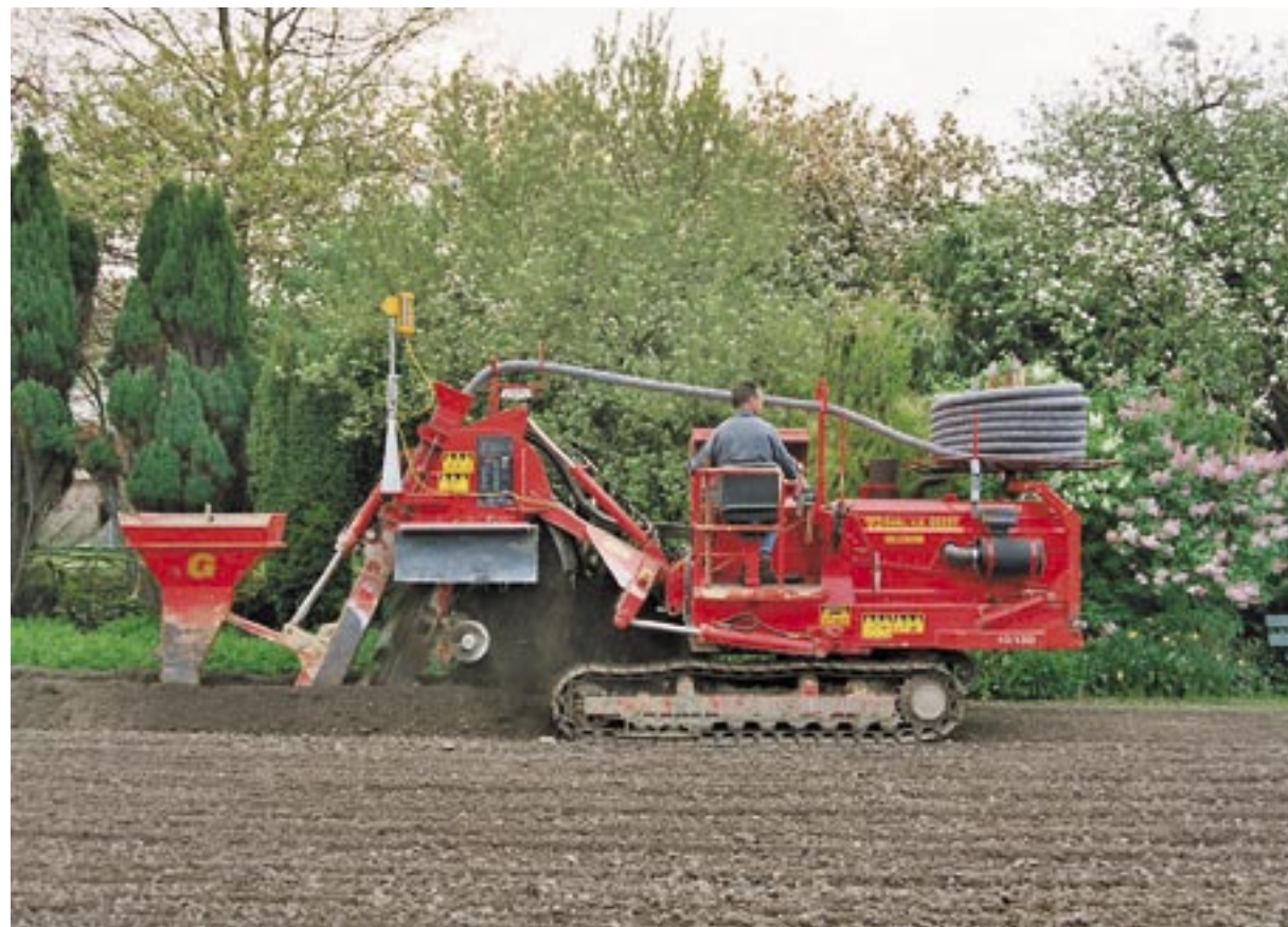
In een werkgang wordt de sleuf gegraven, de drain gelegd en goed doorlatend vulmateriaal opgebracht.
