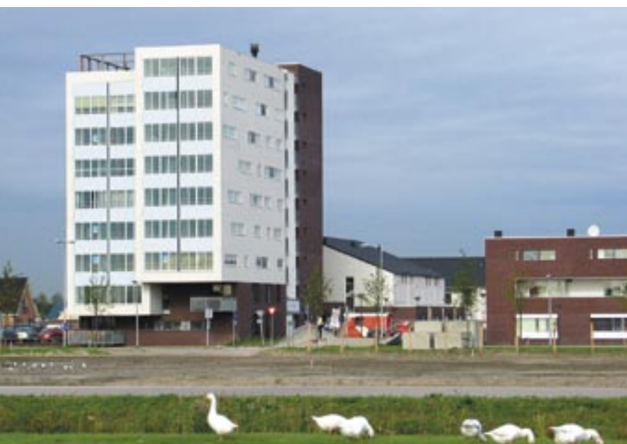
Vlak en zonder bouwafval opgeleverd. Een beplanting zal het er moeilijk hebben als niet eerst de vastgereden grond met stagnerend water erop wordt losgewerkt.
